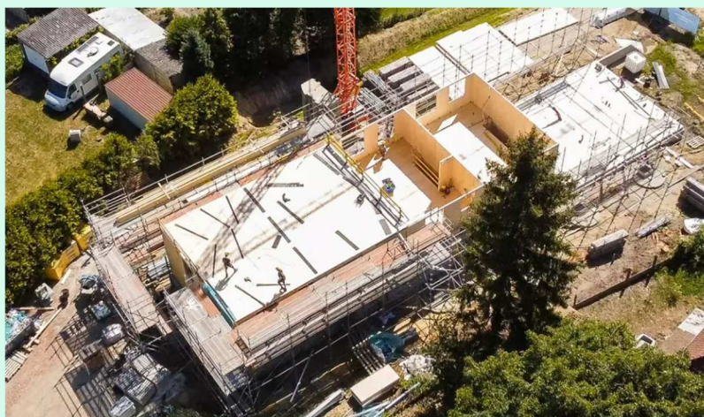
Figuur 22: Ruwbouwfase met zichtbare CLT elementen © Hooyberghs
