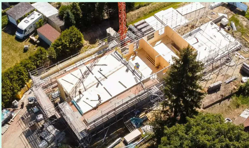
Figuur 22: Ruwbouwfase met zichtbare CLT elementen © Hooyberghs
